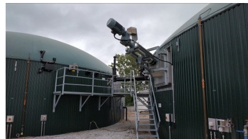
Un méthaniseur agricole et son système d'agitation
