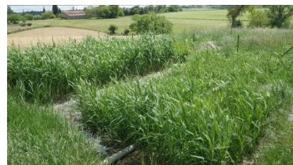
Casiers d'un filtre planté de roseaux
