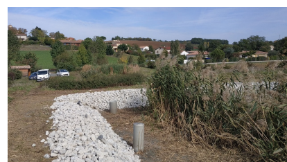
Filtre planté de roseaux après travaux d'enrochement
