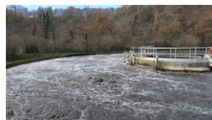
Bassin d'aération d'une STEU à boues activées
