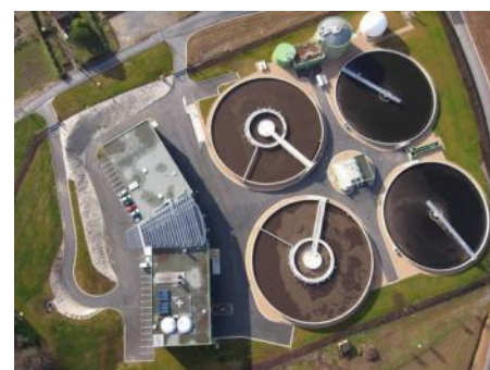
Vue aérienne d'une STEU à boues activées
