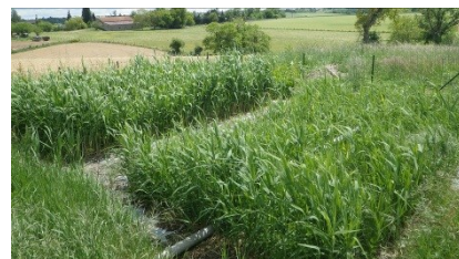
Casiers d'un filtre planté de roseaux
