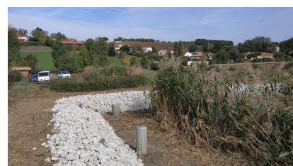
Filtre planté de roseaux après travaux d'enrochement
