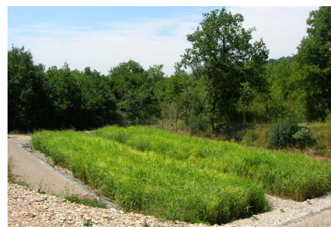
Filtre à sable Planté de Roseaux (FPR)
