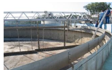
Clarificateur d'une STEU à boues activées
