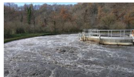
Bassin d'aération d'une STEU à boues activées
