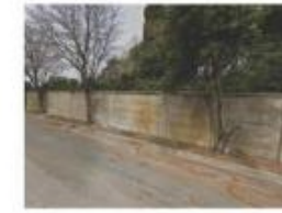
Mur de clôture
