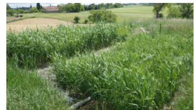
Filtre planté de roseaux
