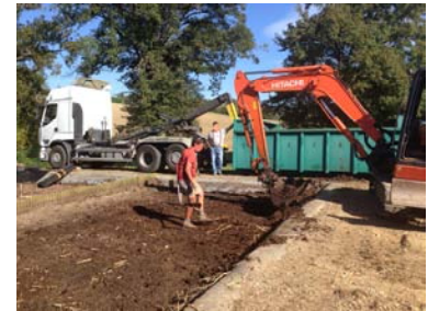
Curage des boues d'un filtre planté de roseaux
