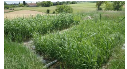
Casiers d'un filtre planté de roseaux
