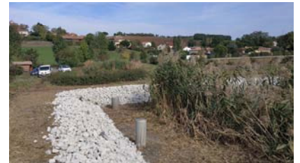
Filtre planté de roseaux après travaux d'enrochement
