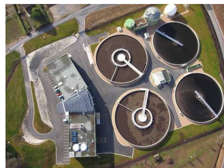
Vue aérienne d'une STEU à boues activées
