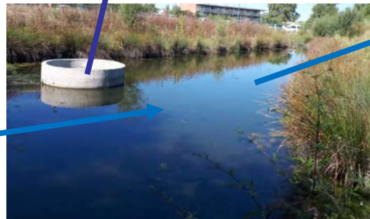
Bassin de décantation
