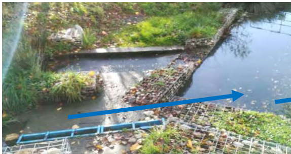
Entrée des eaux pluviales
