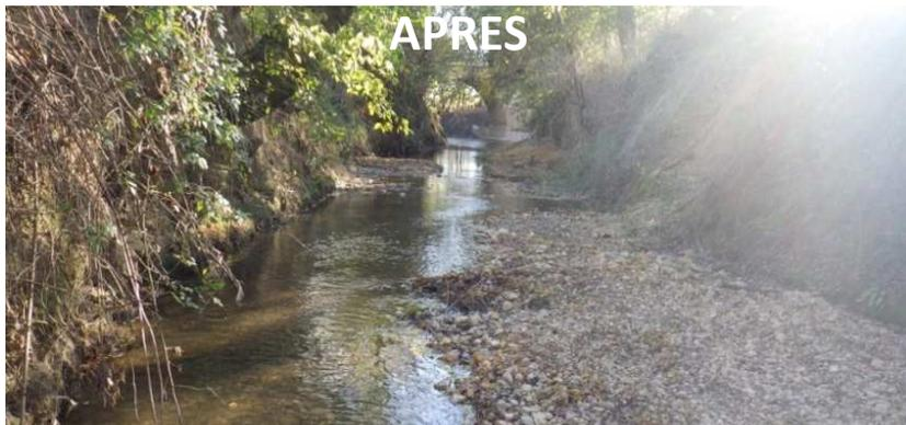
*La mise en place de cette technique sur des contextes de cours d'eau rectifiés et recalibrés permet rapidement et à bas coût de recouvrir une diversité d'écoulement et un décolmatage du lit.*
