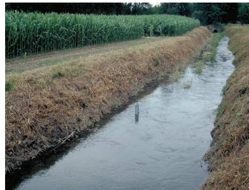
Canal d'irrigation gravitaire non-revêtu dans le bassin de l'Adour
