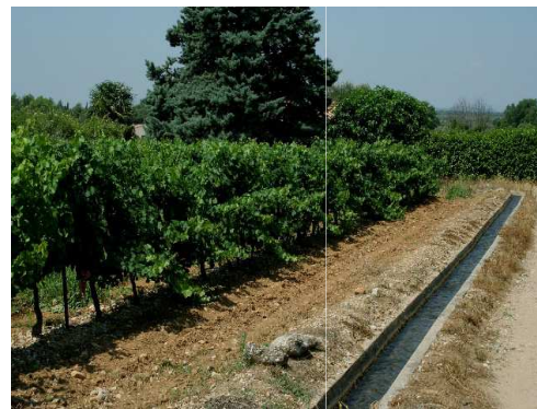
Canalette revêtue, irrigation gravitaire de la vigne (Canal de Gignac)
