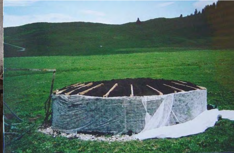
Filtre de compost déchets verts
