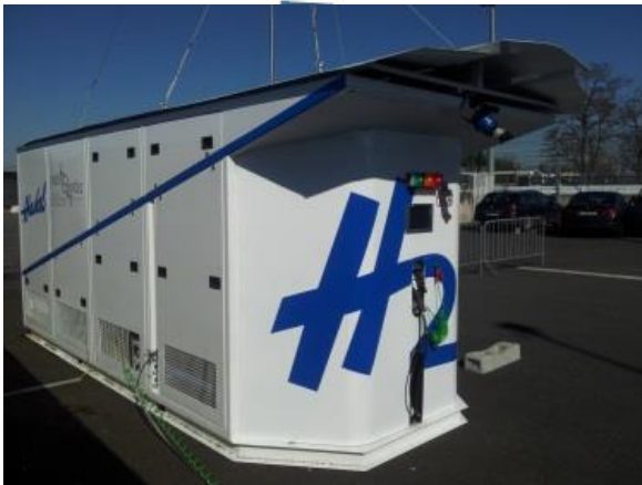
Station-service Hydrogène (15 kg/12h) installée le 21/01/2014 sur le complexe aéroport-autodrome d'Albi-Le Séquestre. Première station-service hydrogène française financée à 100% par des collectivités ; gérée et exploitée par la SEM EVEER'HY'PÔLE
